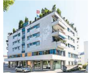
Die Dietiker Finanzabteilung macht sich in dieser Liegenschaft an der Oberdorfstrasse 11 breit.
